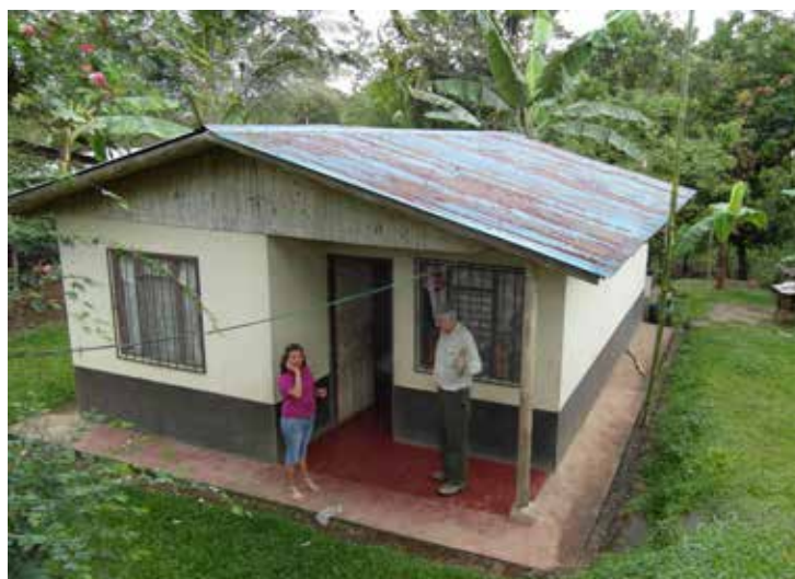
Casa de bahareque encementado, Proyecto Nacional de Bambú, Costa Rica. (Fotografía Sebastián Kaminski)
