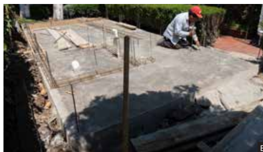
A y B. Proceso constructivo de cimentación, pie de casa con sistema modular encementado, Ciudad de México (Fotografía Bambuterra).
