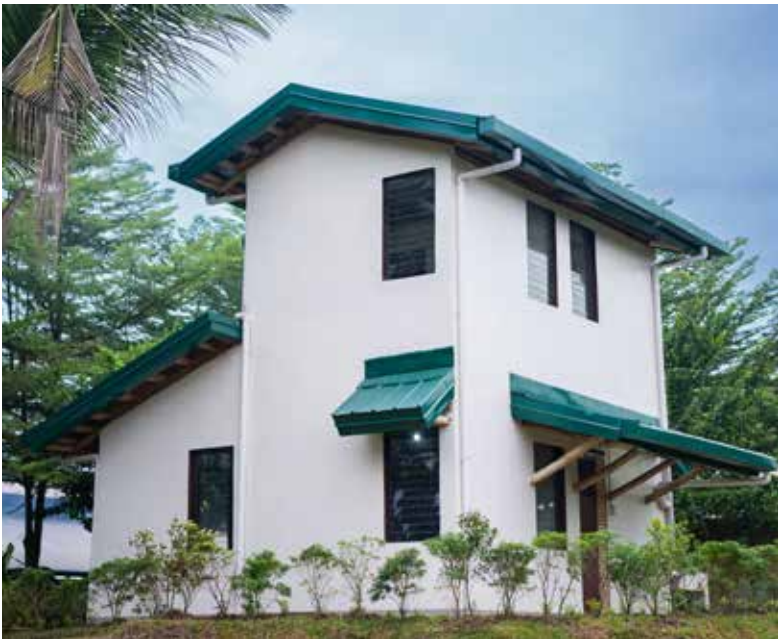
Vivienda de dos niveles, proyecto Base Bahay Foundation, Inc., Davao, Filipinas. (Fotografía Base Bahay Foundation, Inc.).
