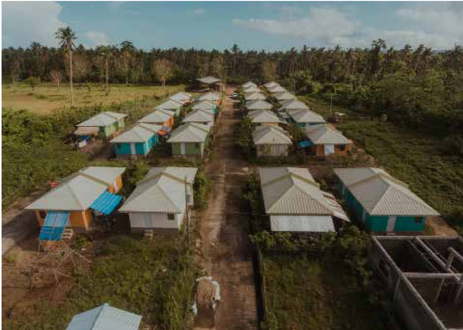
Don Jose Berenguer Bamboo Village, proyecto Base Bahay Foundation, Inc., Davao, Filipinas. (Fotografía Base Bahay Foundation, Inc.).
