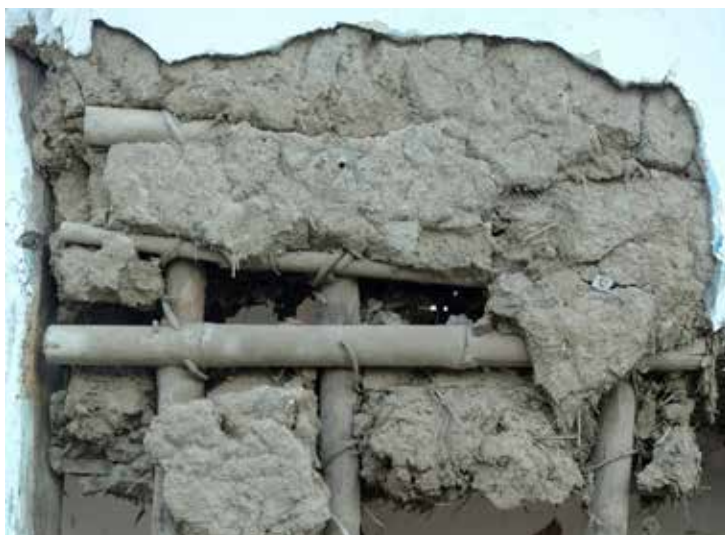
Detalle de muro de bajareque construido con Guadua amplexifolia , Santo Domingo Zanatepec, Oaxaca (Fotografía E. Ruiz-Sánchez).
